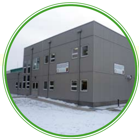
Nouvelles installations pour le secondaire, École Valois
