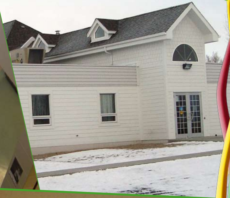
Installation et réaménagement des portatives à l'école Boréale
